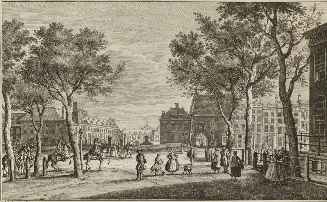
GEZIGT van de KNEUTERDYK, op het STADHOUDERLYK QUARTIER, de NIEWE KERK de PLAATS ROJAAL, de GEVANGEN POORT, het Logement van LEYDEN &c in s HAGE. 1764. de Amsterdam by P. Fouquet Junior.
